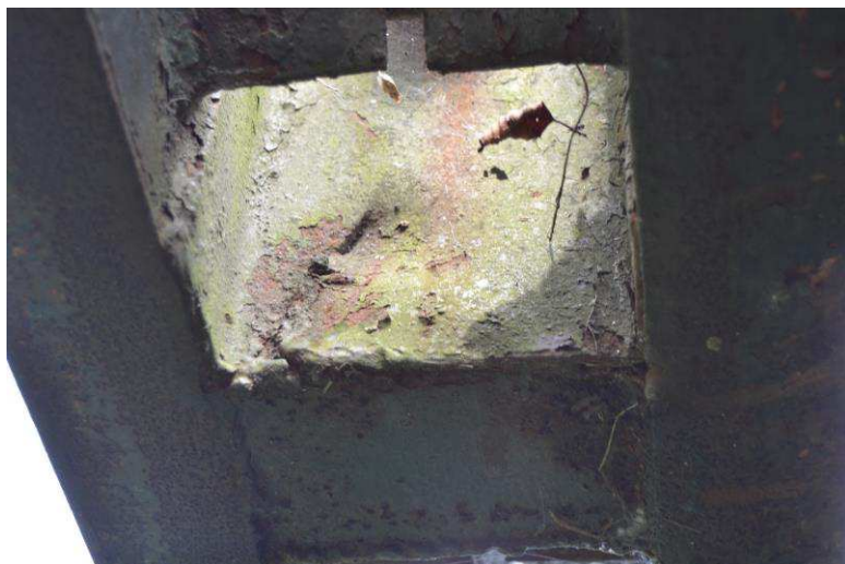
Poškození výztuhy DP hlav. nosníku na 2. dílci vpravo
