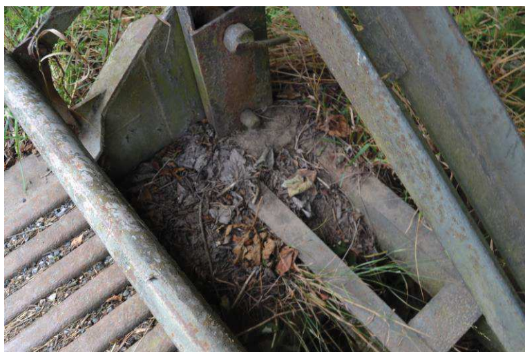
Zanesený úložný práh a zanesený konec NK v místě uložení
