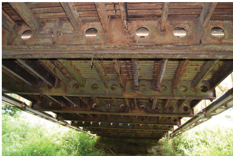
Podhled NK, některé podélníky nahrazeny nebo doplněny válcovanými profily
