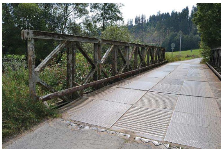
Levý hlavní nosník, vzrostlá vegetace u opěr, trhliny a odlamování živíc u rampovníků
