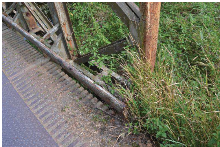
Koroze HN, obrubníků, zanesená mostovka, vegetace na koncích mostu
