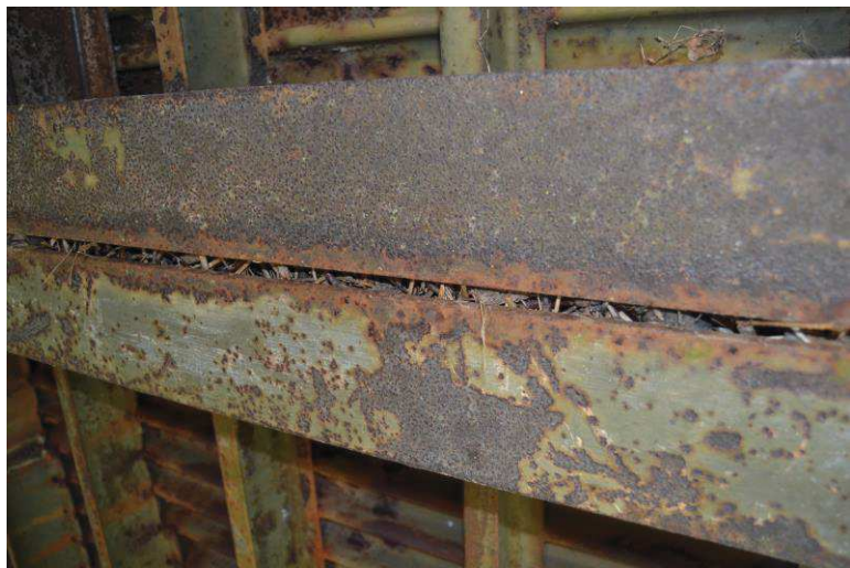
Nánosy (propadlé znečištění) mezi jednotlivými díly konstrukce (mezi příčnicí)
