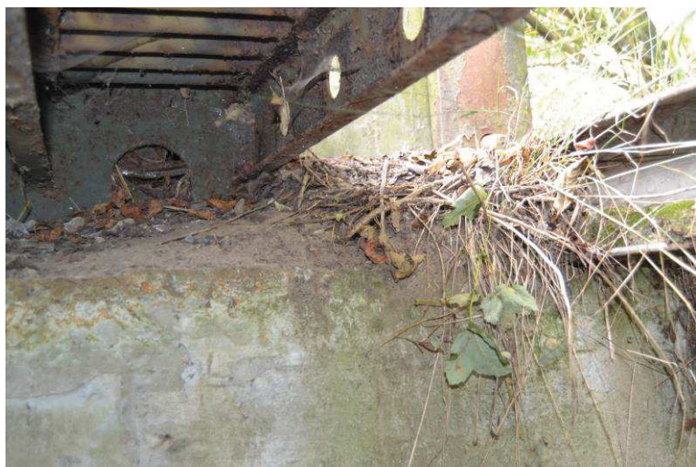
Nánosy na úložném prahu, vegetace
