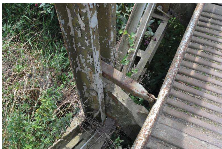
Táhlo obručníku, plošná koroze prvků, zanesená mostovka
