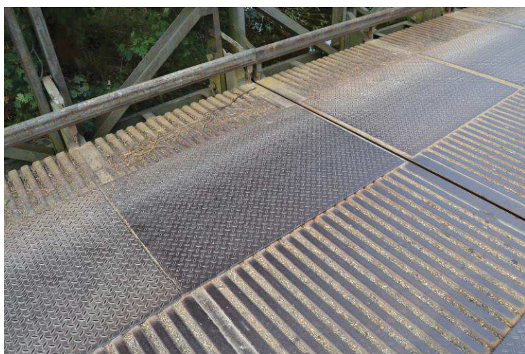
Doplňný plech na mostovce v místě pojezdu vozidel (v místě jízdních stop)
