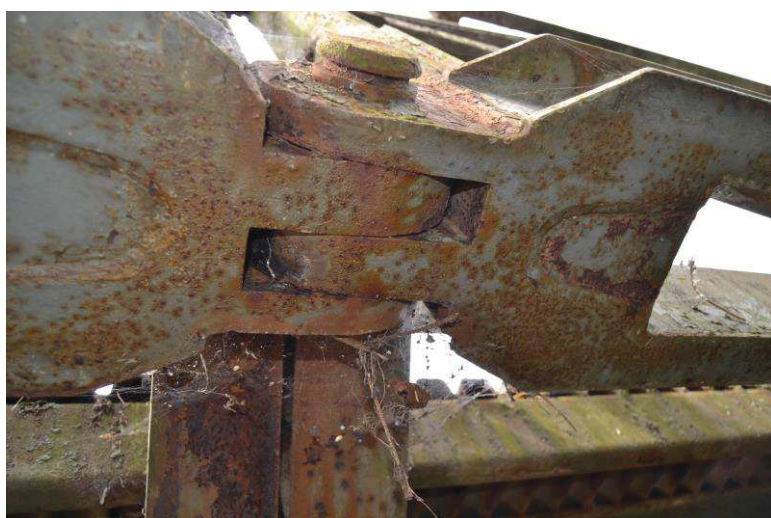
Čepový spoj dolního pasu hlavního nosníku
