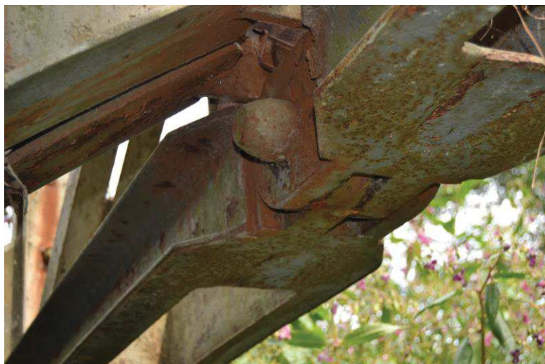
Chybějící závlačka čepového spoje hlavního nosníku na 2. dílci vlevo
