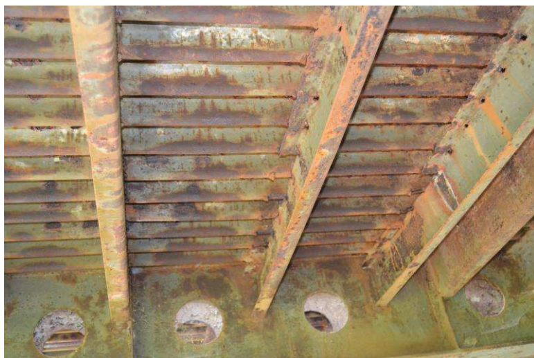
Podhled mostu – koroze mostovkového plechu, chybějící pásnice podélníků, odtržené svary mezi podélníky a mostovkou
