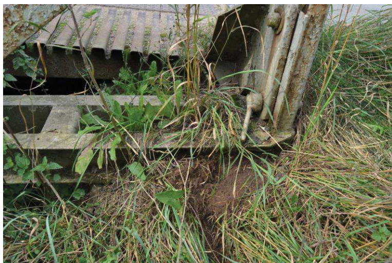
Zanesený práh v uložení, koroze HN
