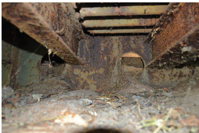
Koncový příčník u OP2, koroze, nánosy na úložném prahu
