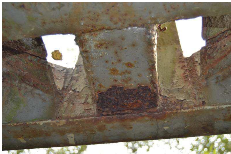
Koroze výztuh hlavního nosníku
