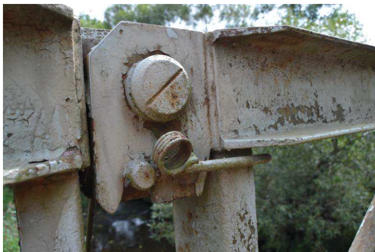
Čepový spoj horní pásnice hlavního nosníku vpravo, zbytky PKO
