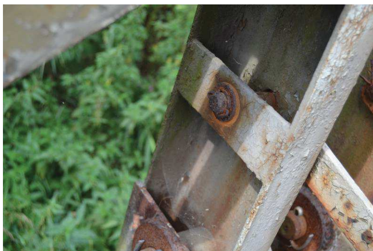
Koroze podložek a závlaček
