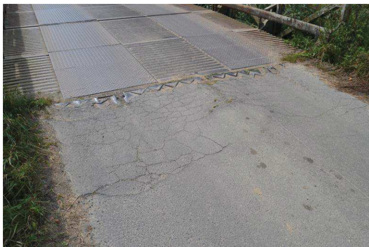
Mozaikové trhliny na vozovce u rampovníků
