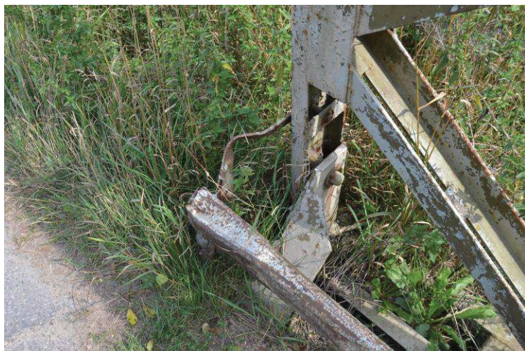
Deformace krajního táhla obručníku vlevo u OP1
