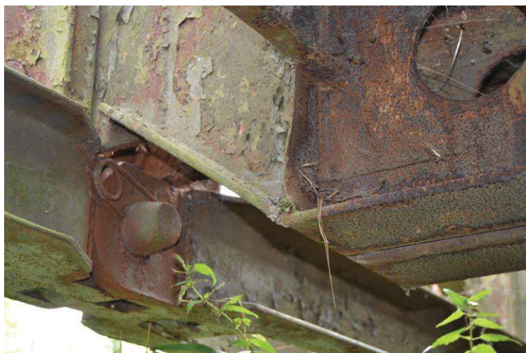
Pohled na čepový spoj HN, napojení příčnicku, koroze, lokální mechanická deformace výztuhy
