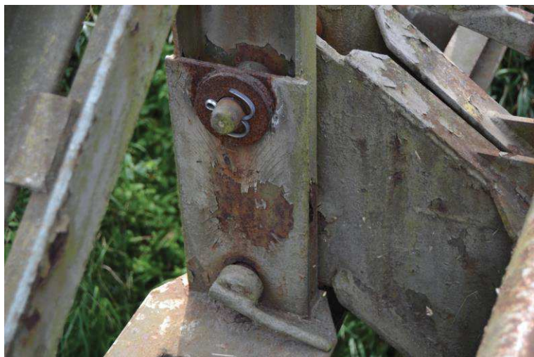
Přivařená podložka, nová závlačka čepu, PKO za hranicí životnosti
