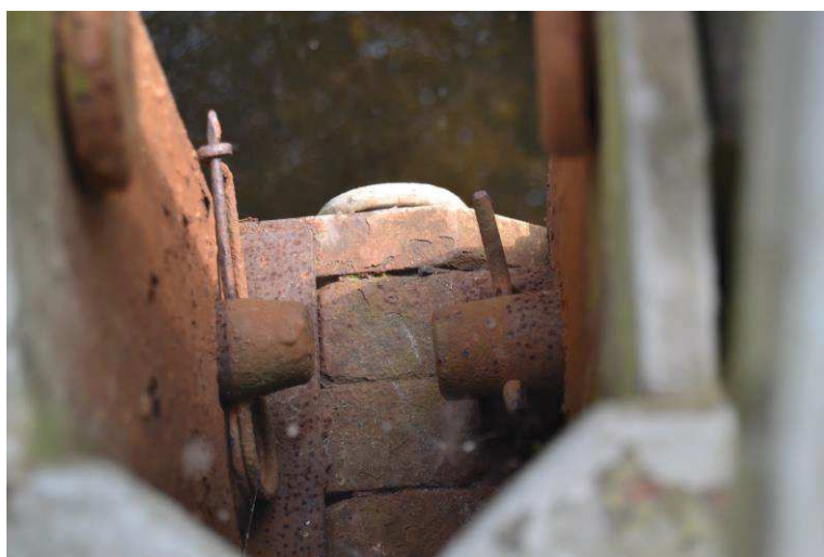
Pohled na otočné čepy a na hlavní spoj dílů na dolní pásnici
