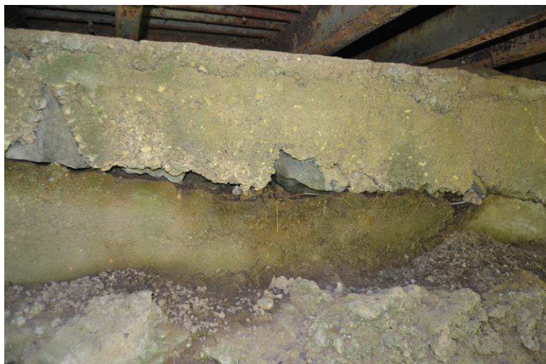
Pohled na OP1, nekvalitní, kameny s betonem, zvodnělé pracovní spáry, kaverny
